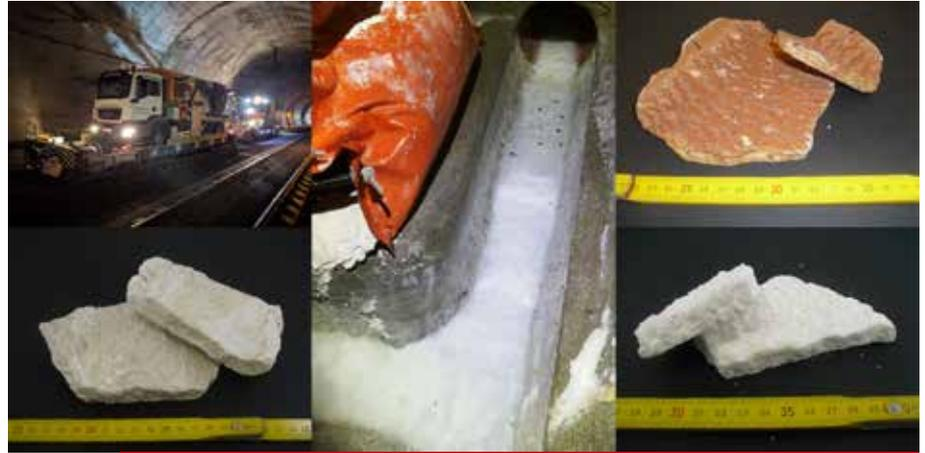
Drainage-Reinigung mittels Hochdruckspülung und unterschiedliche Ablagerungen aus Tunneldrainagen [2]
